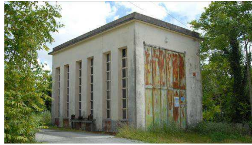
Figure 44 : station de pompage de Chalézac à Chaillevette (source : Communauté d'Agglomération de Royan Atlantique)
