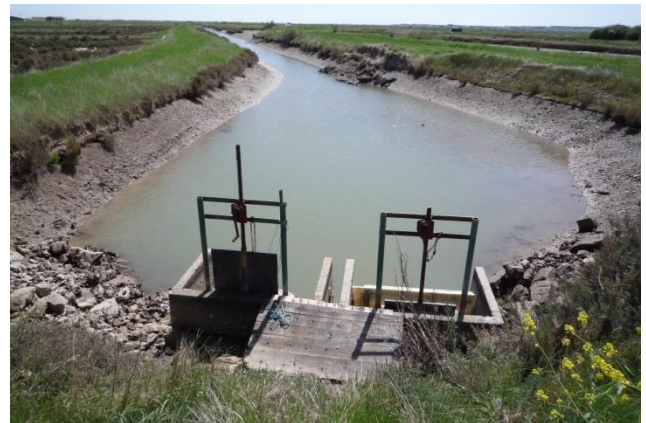
Figure 27 : Taillées en bord de chenal dans le marais salé (source SMASS)
