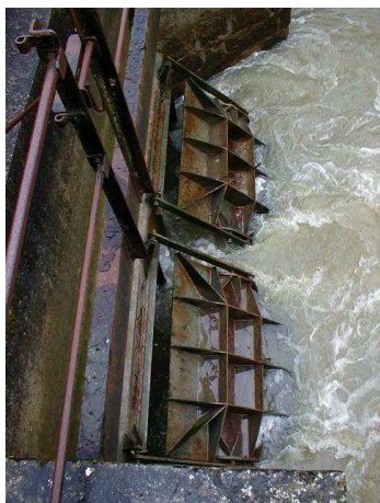
Photographie 12 : Clapets anti-retour de l'écluse de La Poterie à Chaillevette.
