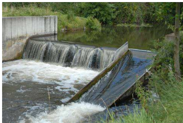
Photographie 19 : Passe à canoë du barrage de Charloteau
