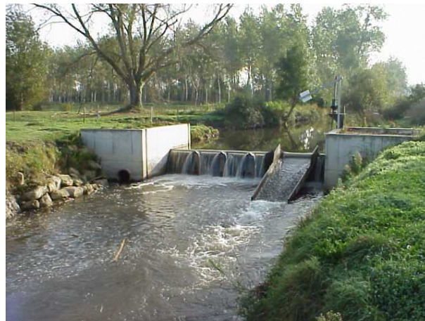
Photographie 7 : Clapets mobiles du Barrage de Charloteau à Corme-Ecluse.
