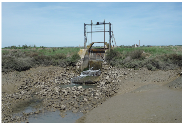
Photographie 4 : Vanne simple vantelle ou varagne à Nieulle-Sur-Seudre
